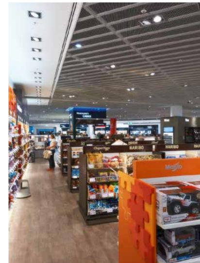
Über Schlitzschiene wird die konditionierte Luft zugluftfrei in die Verkaufsräume eingeblasen.
